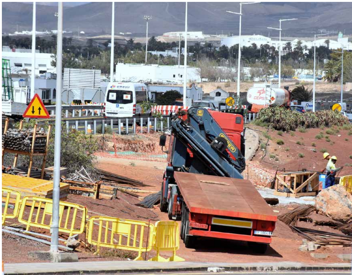
Las obras del paso subterráneo de Playa Honda, de las pocas actuaciones nuevas en Lanzarote.
