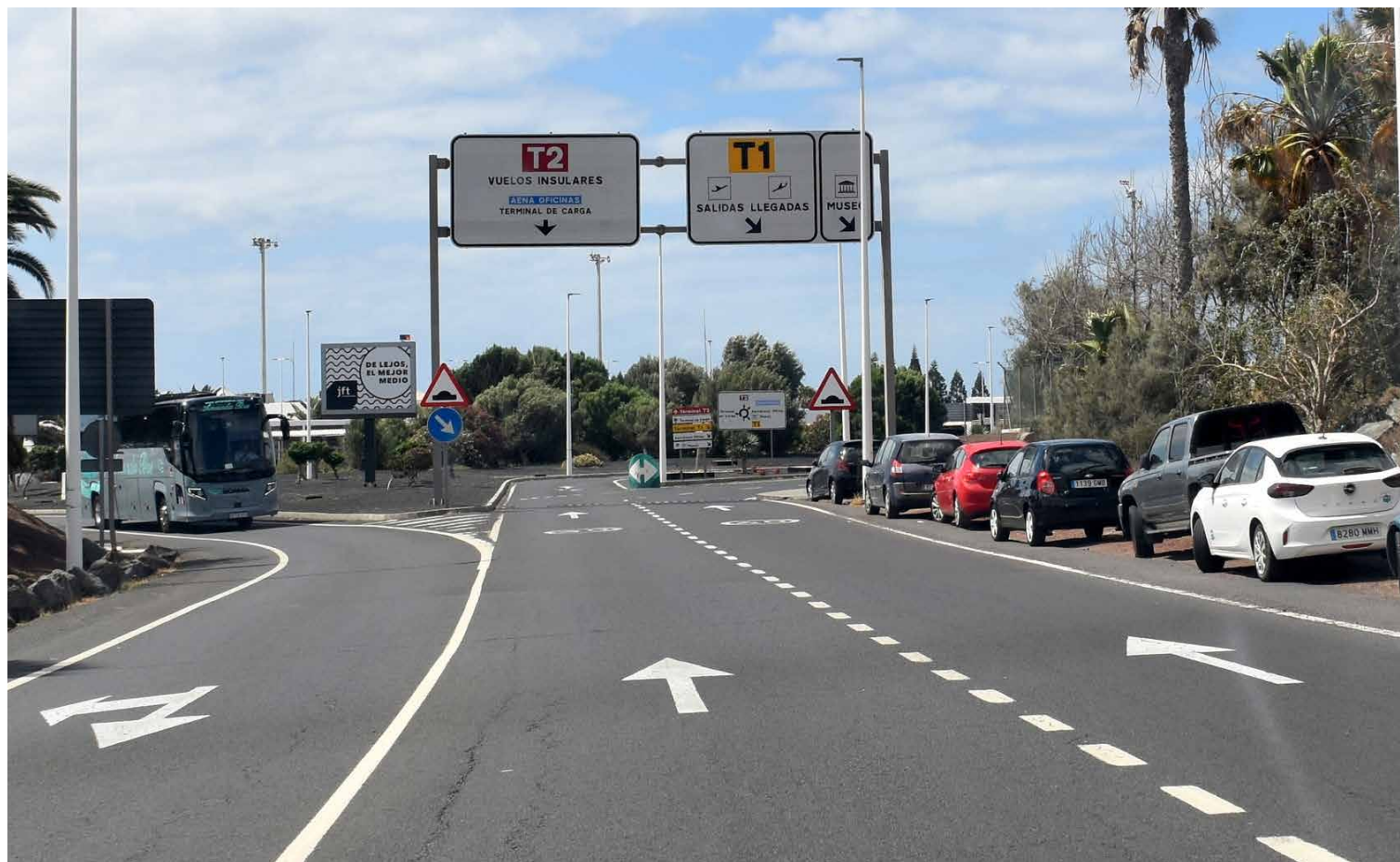
La carretera Lanzarote 5 conectará el aeropuerto y el Hospital General.
